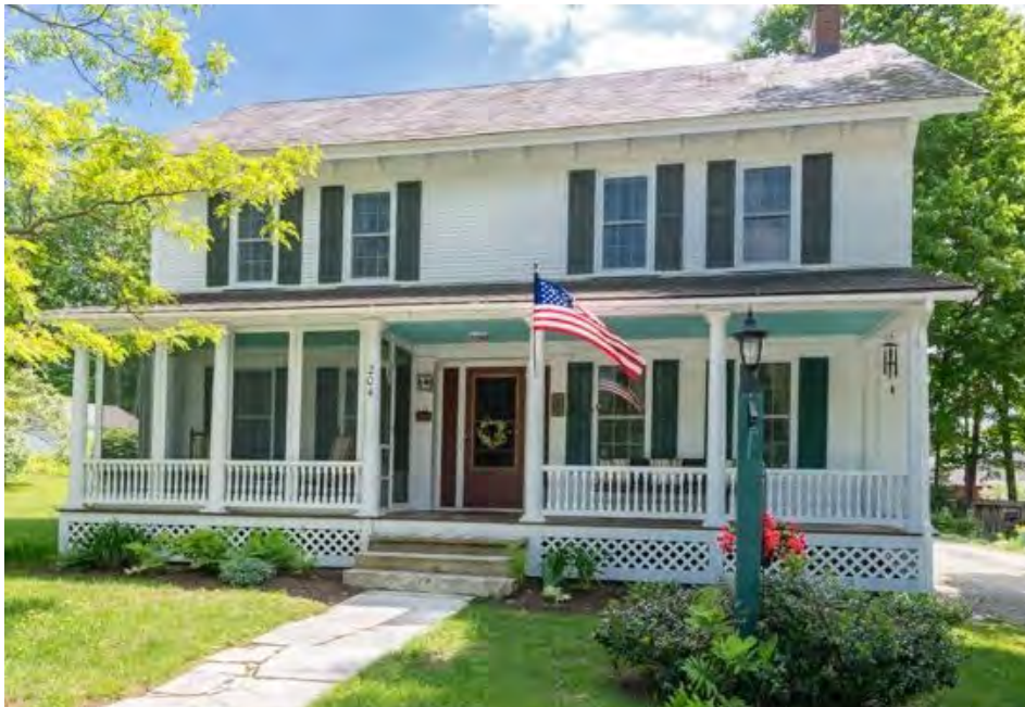
204 Mad Tom Rd, west façade
