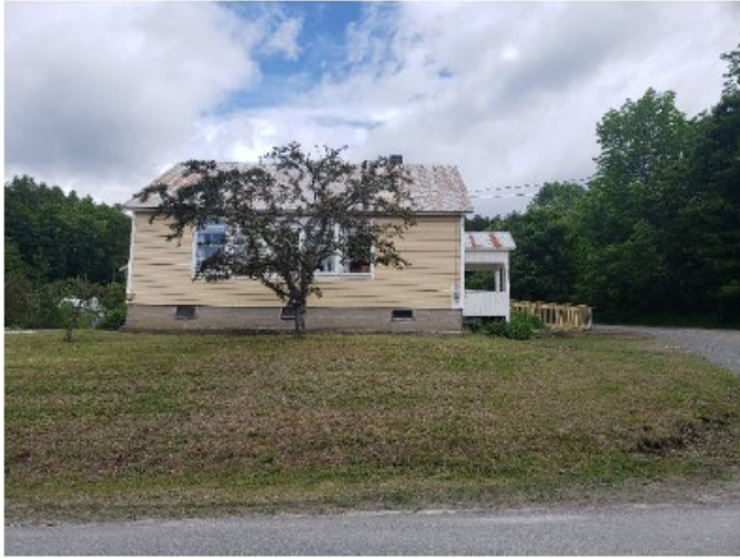
I: Riverside Grange 455
