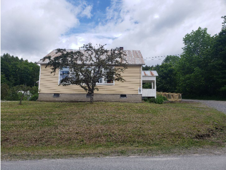
I: Riverside Grange 455
